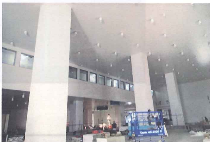
7街区水産卸売場棟卸売場
