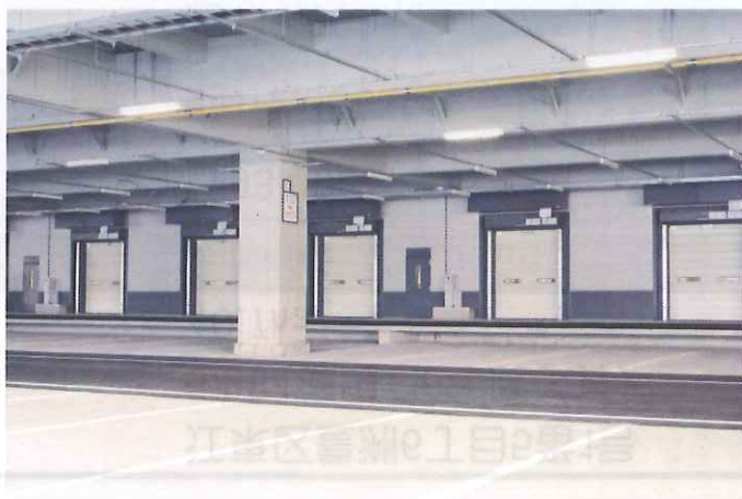
6街区水産仲卸売場棟バス外観
