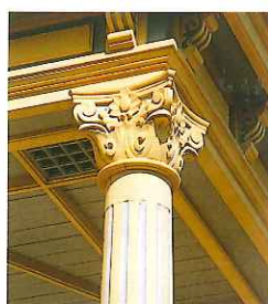
2階ベランダ柱頭飾 (CARVED ORNAMENTS ON THE COLUMN)
