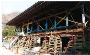
工事中の本堂
