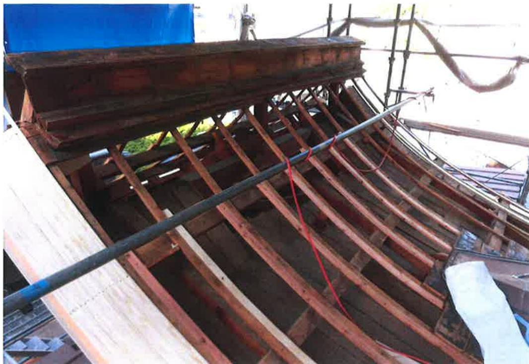
野地板の取り換え
