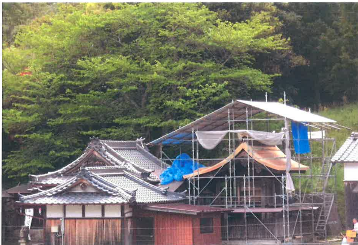
野地板の張替え完了
