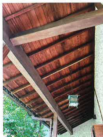
客殿軒裏 補修
