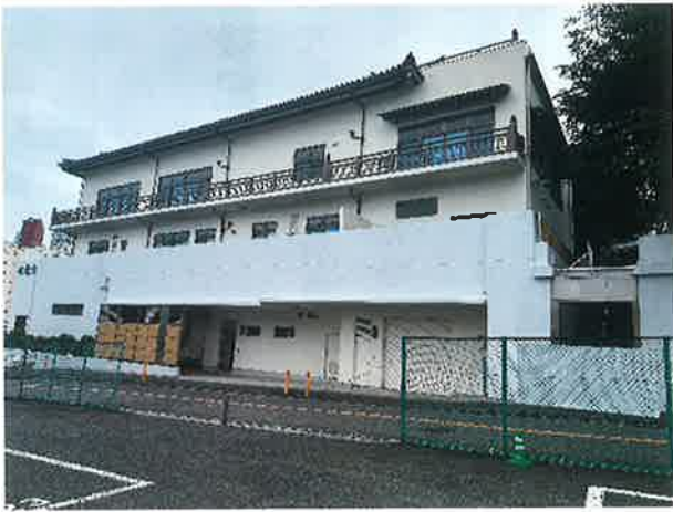
客殿・庫裡 壁塗替え
