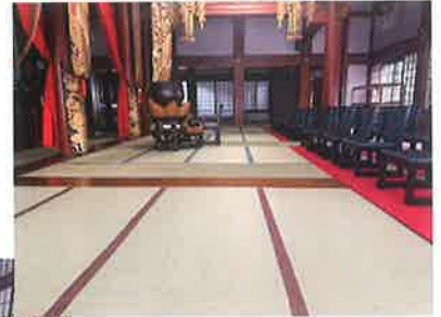
本堂敷居板 補修
