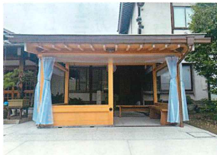
東屋(休憩所) 新設
